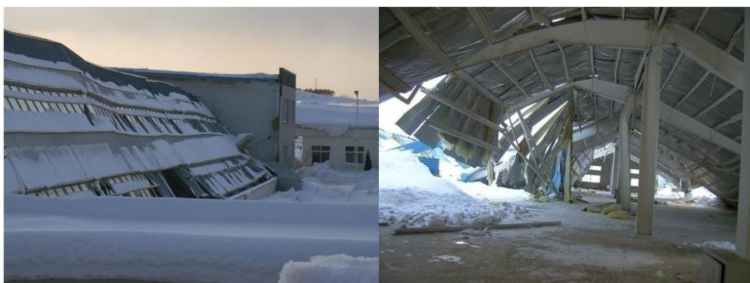
图 1.7 山东威海某钢结构厂房雪毁照片
