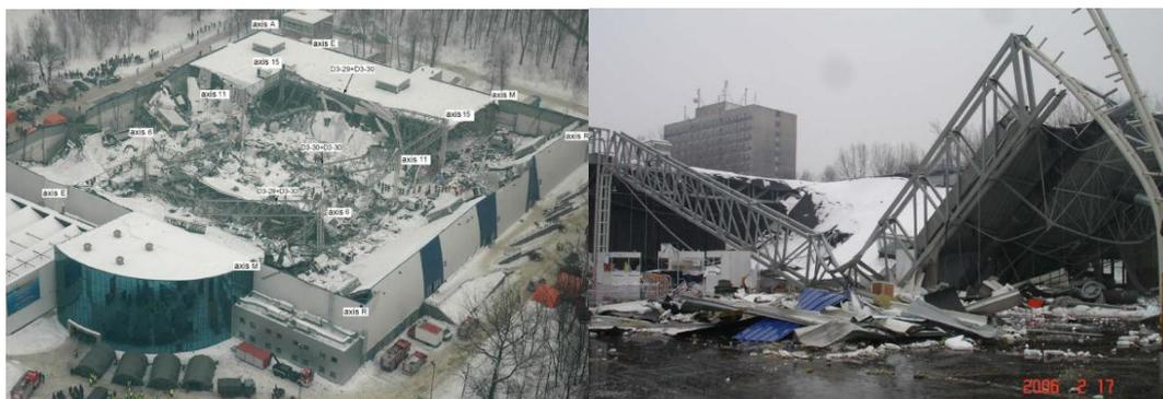
图 1.3 波兰卡托维茨国际博览会展厅雪毁照片(新浪网, 2006)
