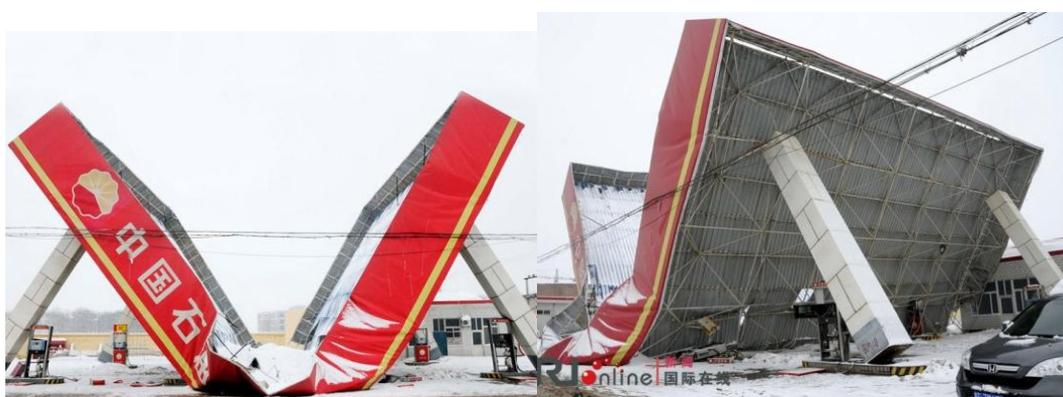
图 1.6 河北邢台加油站雪毁照片(新浪网, 2009)
